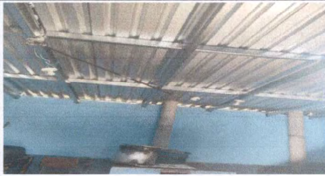
Foto 1: Sustrucción de lámina por lámina aluzinc 26 en techo de cocina.
