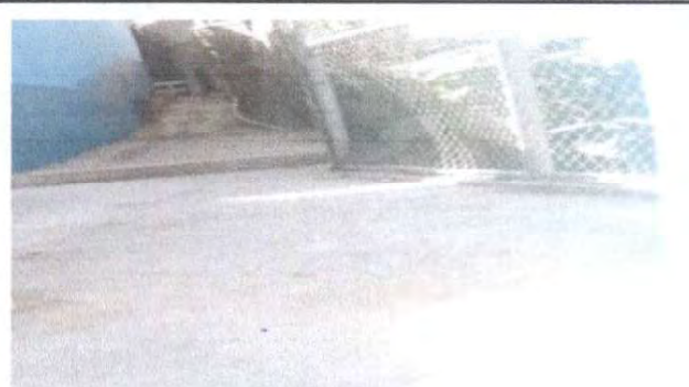
Foto 10: Reparación de planchas de concreto de patio.
