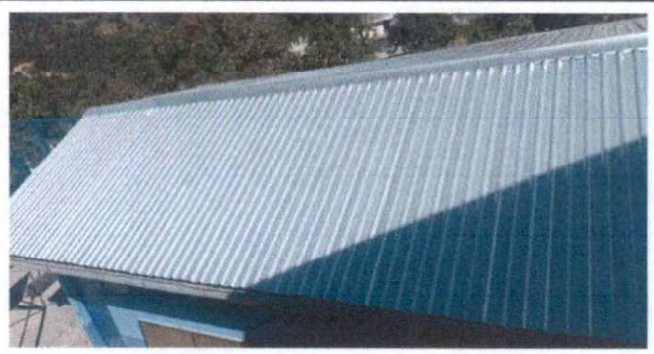
Foto 2: Sustrucción de capotes lámina por lámina troquelada. En dos aulas de primaria.
