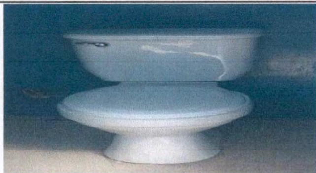
Foto 7: Sustrución de inodoro.
