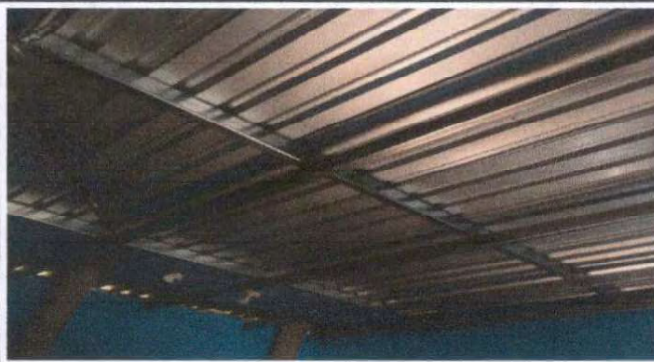
Foto 3: Sustrucción de estructura de soporte de madera por metal en techo de cocina.
