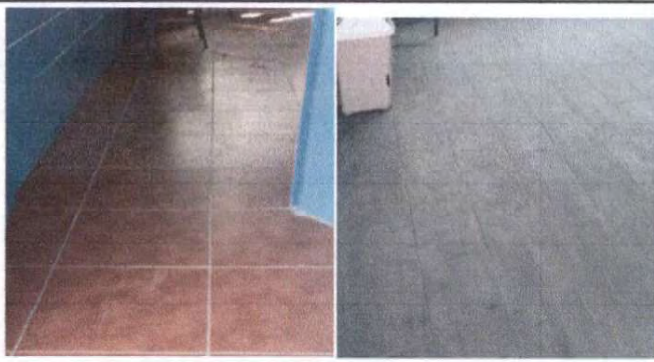
Foto 4: Sustrucción de piso de cemento líquido por piso cerámico en aulas y cocina.
