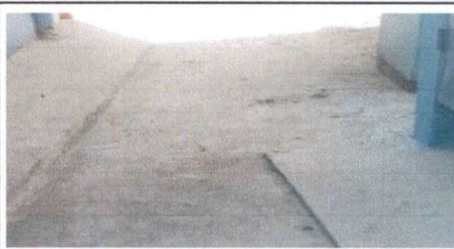
Foto 8: Sustrución de tubería PVC línea principal de aguas negras.
