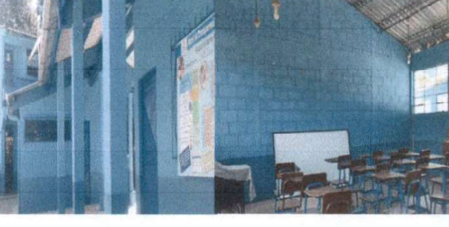
Foto 6: Pintura en exteriores e interiores.
