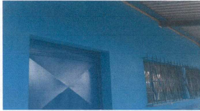
Foto 14: Reparación de paredes (sellado de dos aulas de primaria, una hilera de block.)
