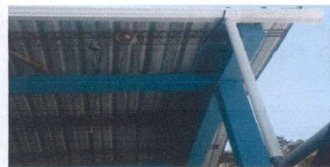
Foto 5: Sustrucción de canal y bajada de agua pluvial en segundo nivel.
