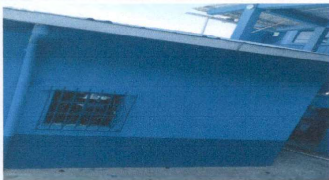
Foto 13: Reparación de paredes (sellado de un aula pequeña)
